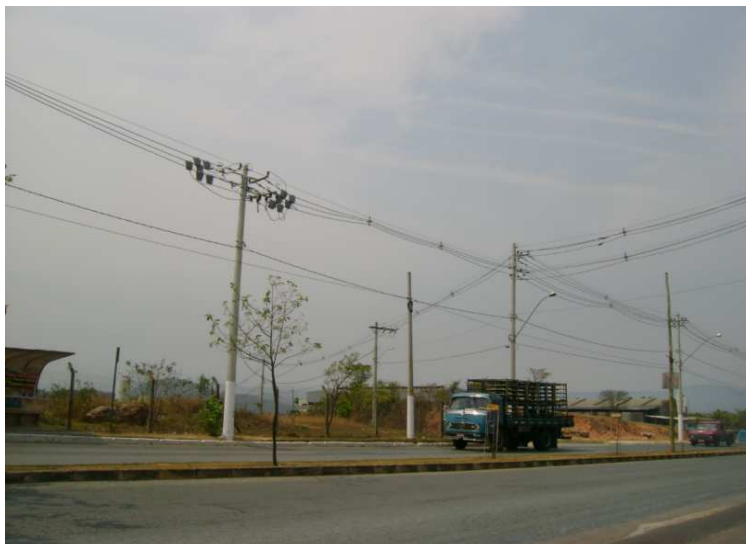
Figura 2.2 - Rede de Distribuição Compacta.
