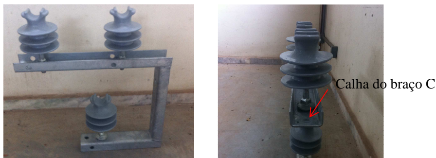
Figura 5.24 – Detalhe da calha do suporte braço C da estrutura CE2
