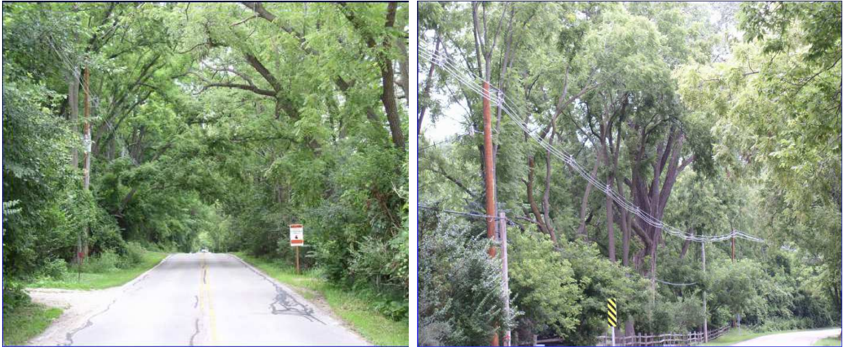
Figura 2.1 - Rede de Distribuição Aérea Compacta Estados Unidos. Retirado do catálogo Hendrix Co (2014).
