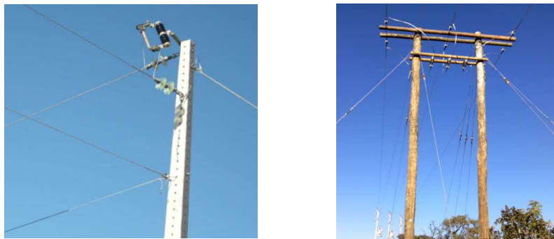
Figura 1.1 – Rede de distribuição convencional urbana de 13,8 kV.
