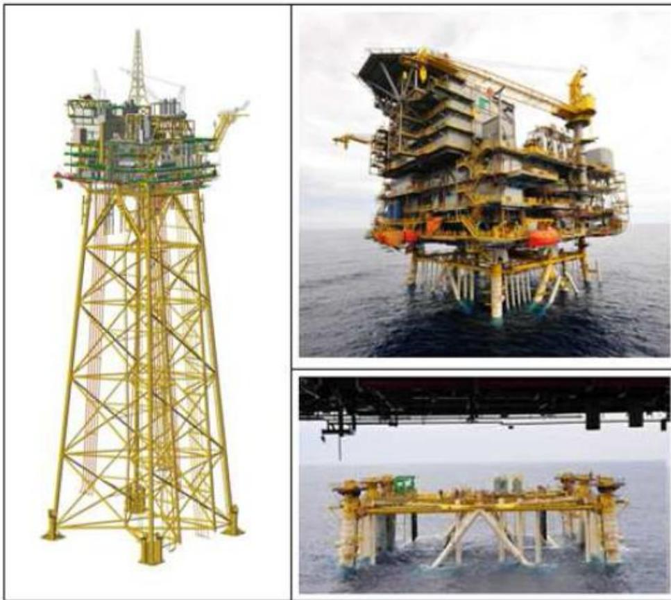
Figura 2.8 - Exemplo de plataforma fixa com subestrutura do tipo jaqueta. Fonte: (OLIVEIRA, 2013).
