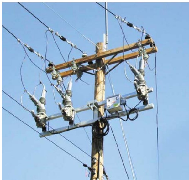
Figura 2 - Religador OVR-3SP da ABB (ABB)
